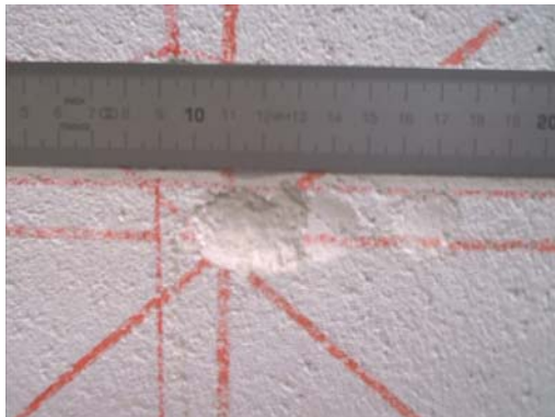
Fig.22: Danos pouco significativos no reboco resultante dos ensaios DURO 1 e DURO 0,5 (Face de impacto)
