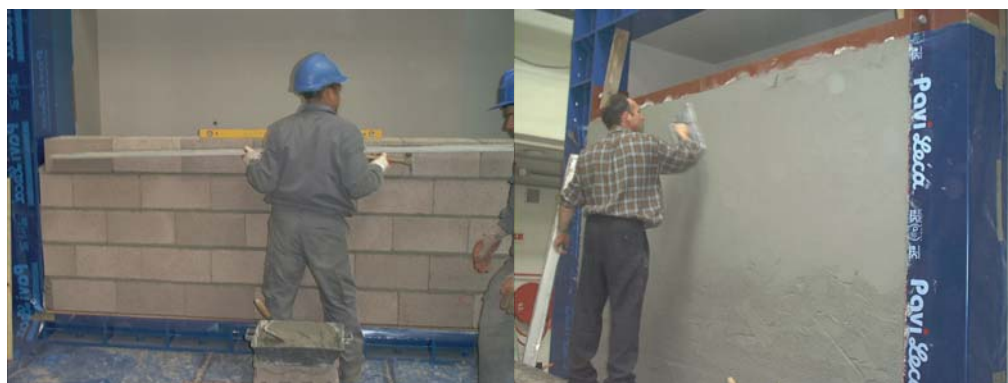
Fig.9: Representação de algumas das fases construtivas da parede experimental
